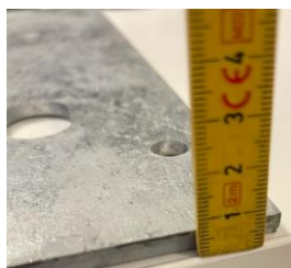
Bilder av stålplaten som falt ned
